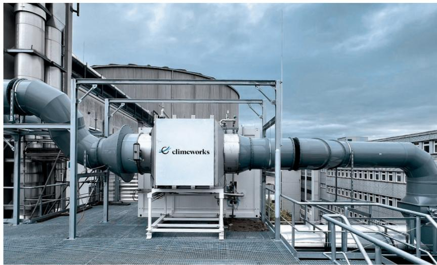
Abbildung 2: In die Lüftungsanlage integrierte DAC-Anlage von Climeworks
